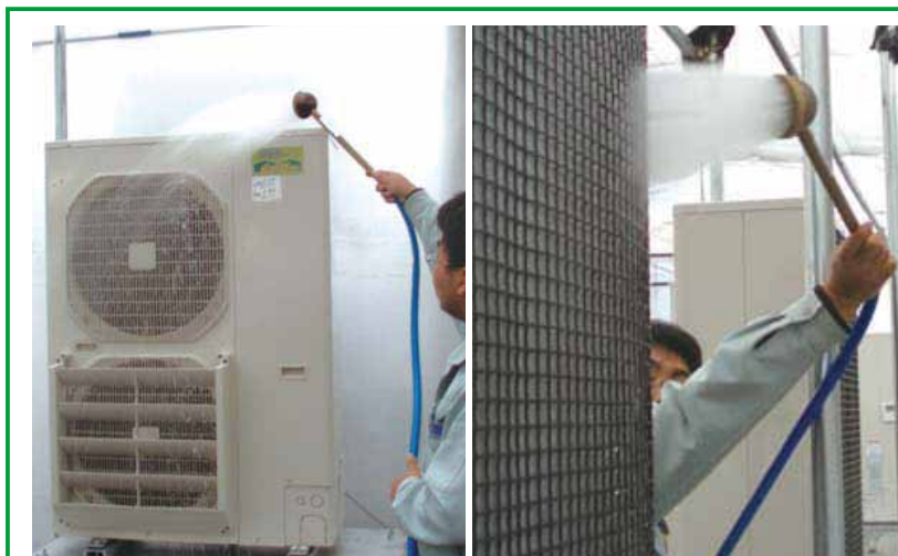
胡蝶蘭栽培施設の方が、ハウス内ユニットを水洗いする様子
